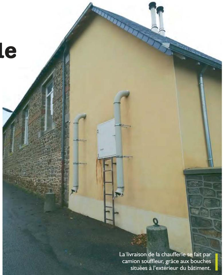
La livraison de la chaufferie se fait par camion souffleur, grâce aux bouches situées à l'extérieur du bâtiment.
